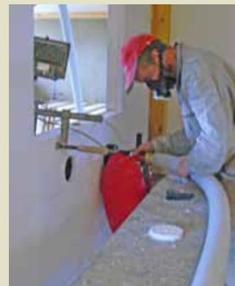
la machine à insuffler la ouate de cellulose : une partie fixe et une partie amovible, un tuyau souple qui permet de parcourir tout le bâtiment et remplir les différentes cloisons.
