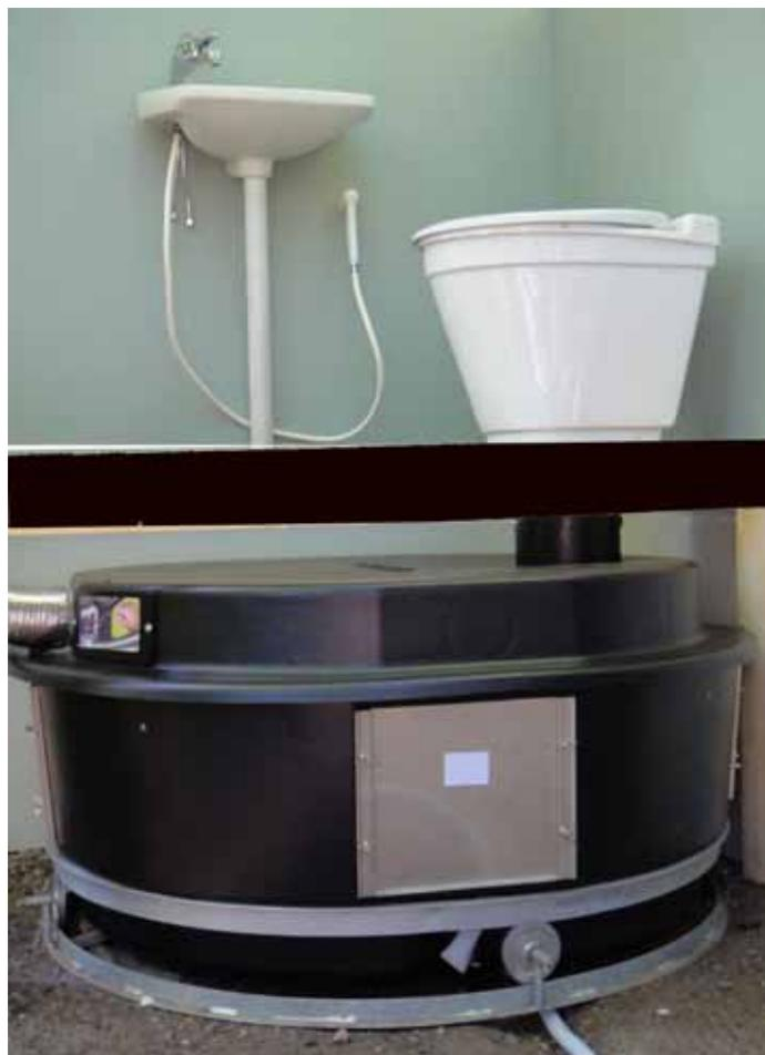
Composteur de 650 l avec évacuation des lixiviats par un tuyau
