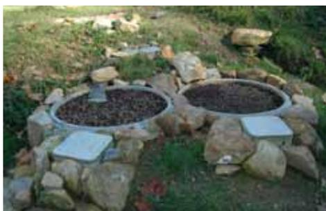
1<sup>er</sup> niveau de traitement vertical aérobique fonctionnant en alternance et par bâchée
