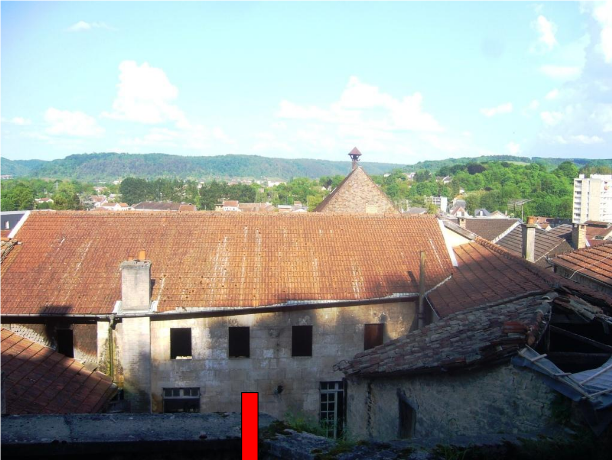
Élévation Ouest du corps principal sur cour
