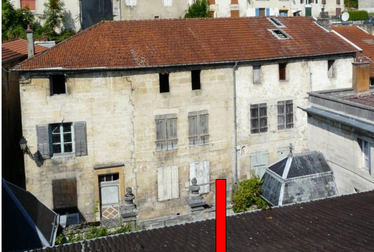
Élévation Est du corps principal sur rue
