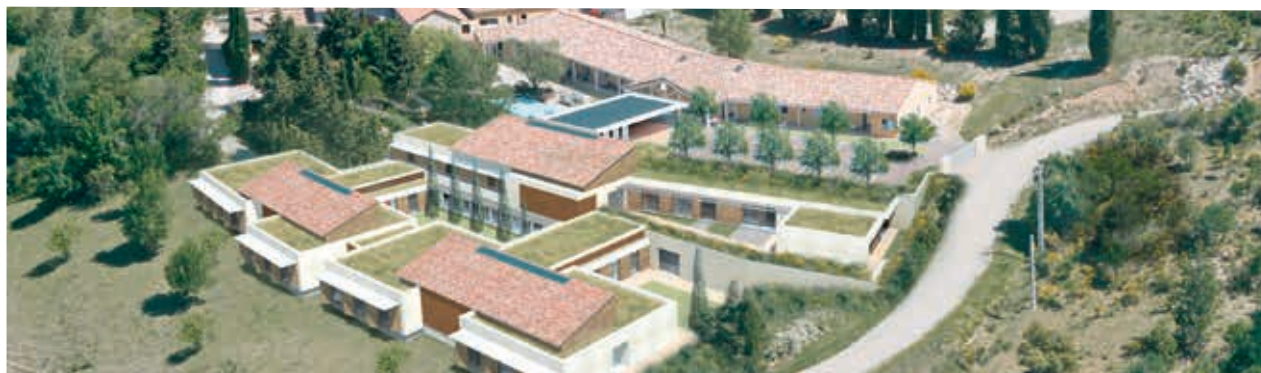
La Motte-Chalancon - Restructuration du « Foyer Clair Matin »
