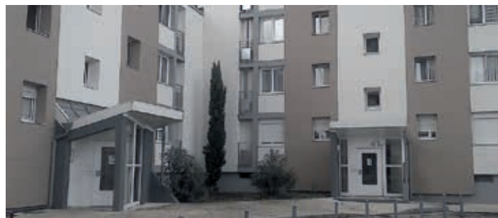
Pierrelatte - « Quartier du Rocher » - Bâtiments 37 à 41 - 90 logements
