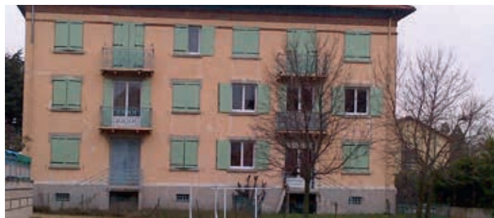
Portes-lès-Valence - « Cité Ouest » - 48 logements
